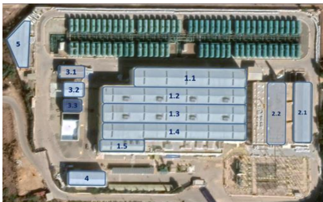
Toiture couverte par les panneaux solaire sur la station de production
