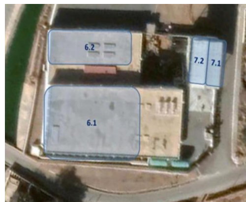
Toiture de station de captage
