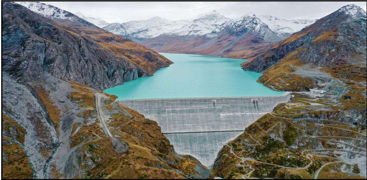
Figure I.3: Photo d'un barrage poids la Grande Dixence (Suisse)(Photo Jérémy Toma).
