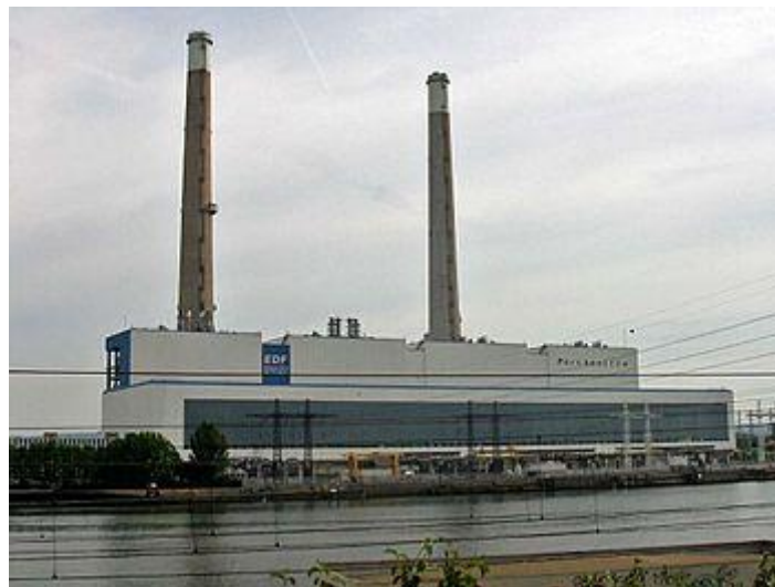
Figure : I.1 Centrale thermique de Porcheville fonctionnant au fioul lourd.
