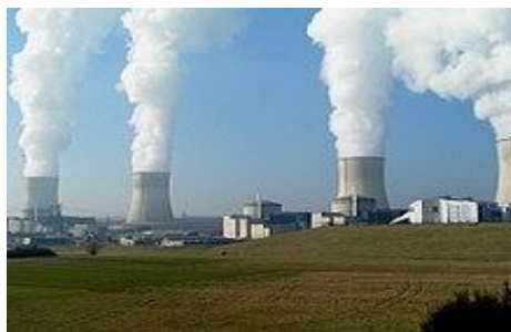
Figure I. 3 : Centrale nucléaire de Cattenom
