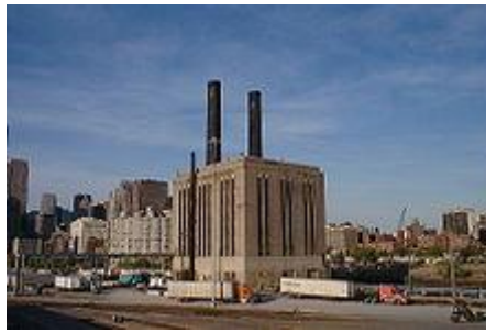
Figure I.2 : Centrale thermique à flamme de Chicago (USA)
