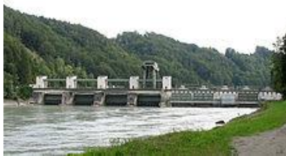
Figure I.5 : Centrale hydroélectrique en Allemagne
