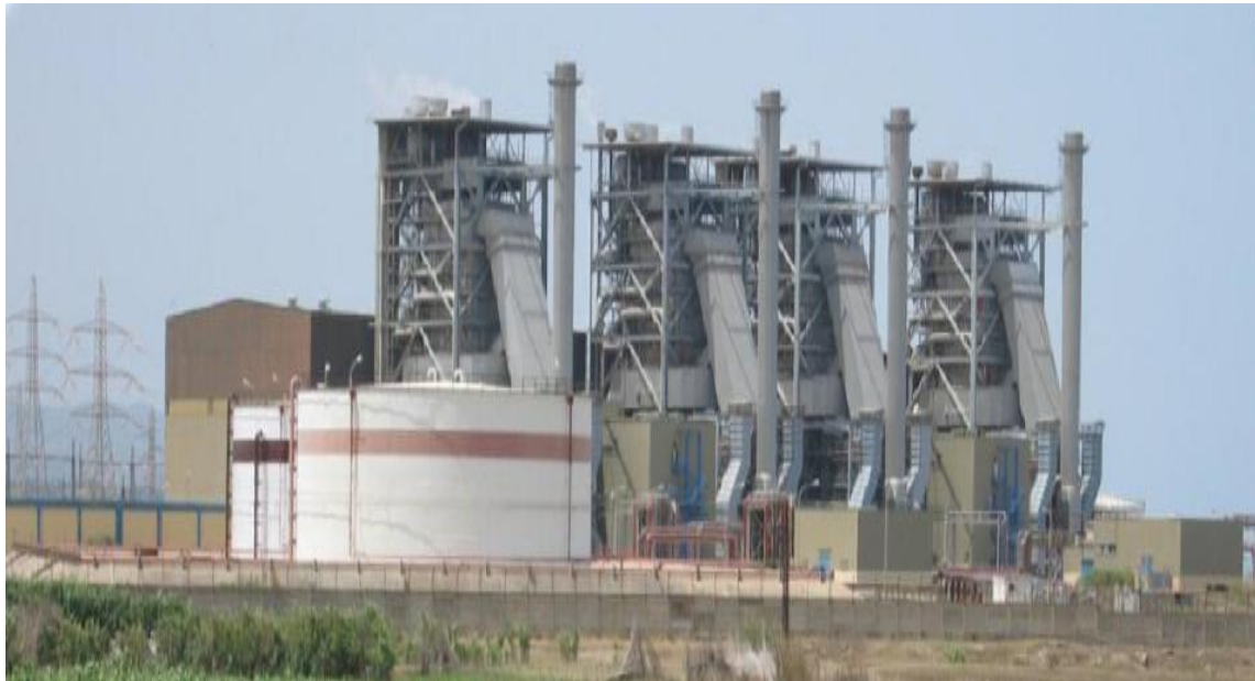
FigureII. 1: La centrale thermique de RAS-DJINET.
