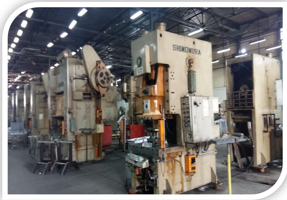
Figure n°12 : presse hydraulique (ENIEM)
