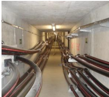
Figure(I-7) Ligne souterraine
