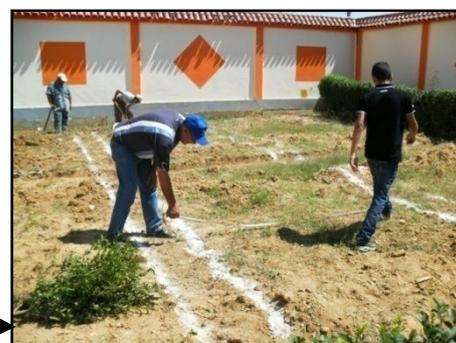
**Figure 37 :** Traçage du plan sur terrain
