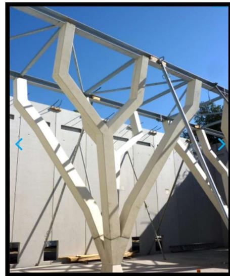
Figure III.41 : image d'un poteau préfabriqué.
