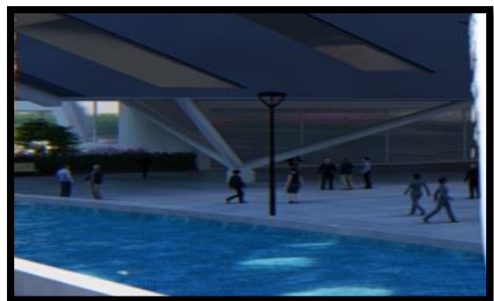
Fig.163. Vue sur le tri-pied Source : auteurs
