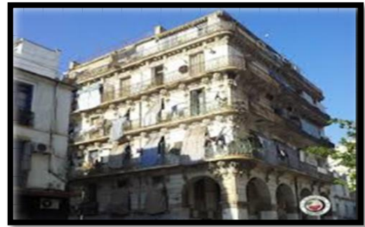
Fig. 35. Façade de style néoclassique Source : prise d'auteurs
