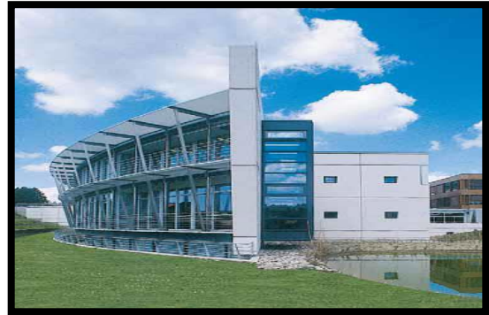
Fig.91. Le bâtiment de l'école Source : 797-ecole-hoteliere-de-lausanne-t10-789
