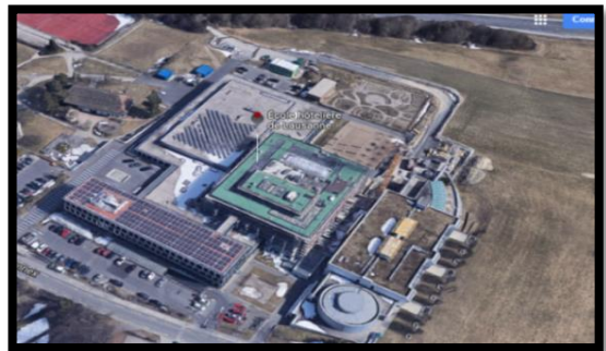
Fig. 86. Vue aérienne sur l'école Source: https://www.google.com/search?q=lausanne+ecole+hoteliere
