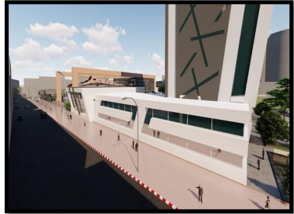
Fig.135. Façade Sud. Source : auteurs
