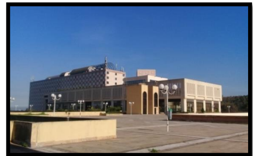
Fig. 37. Hôtel Sofitel Source : prise d'auteurs.
