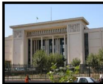
Fig. 25. Bâtiment type Moderne Siege de l'UGTA, Source : http://www.google-
