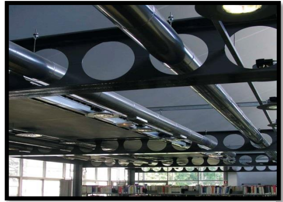
Fig.151. Poutre alvéolaire
