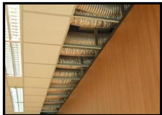
Fig.177. : le faux plafond Source : www.fauxplafonds.org
