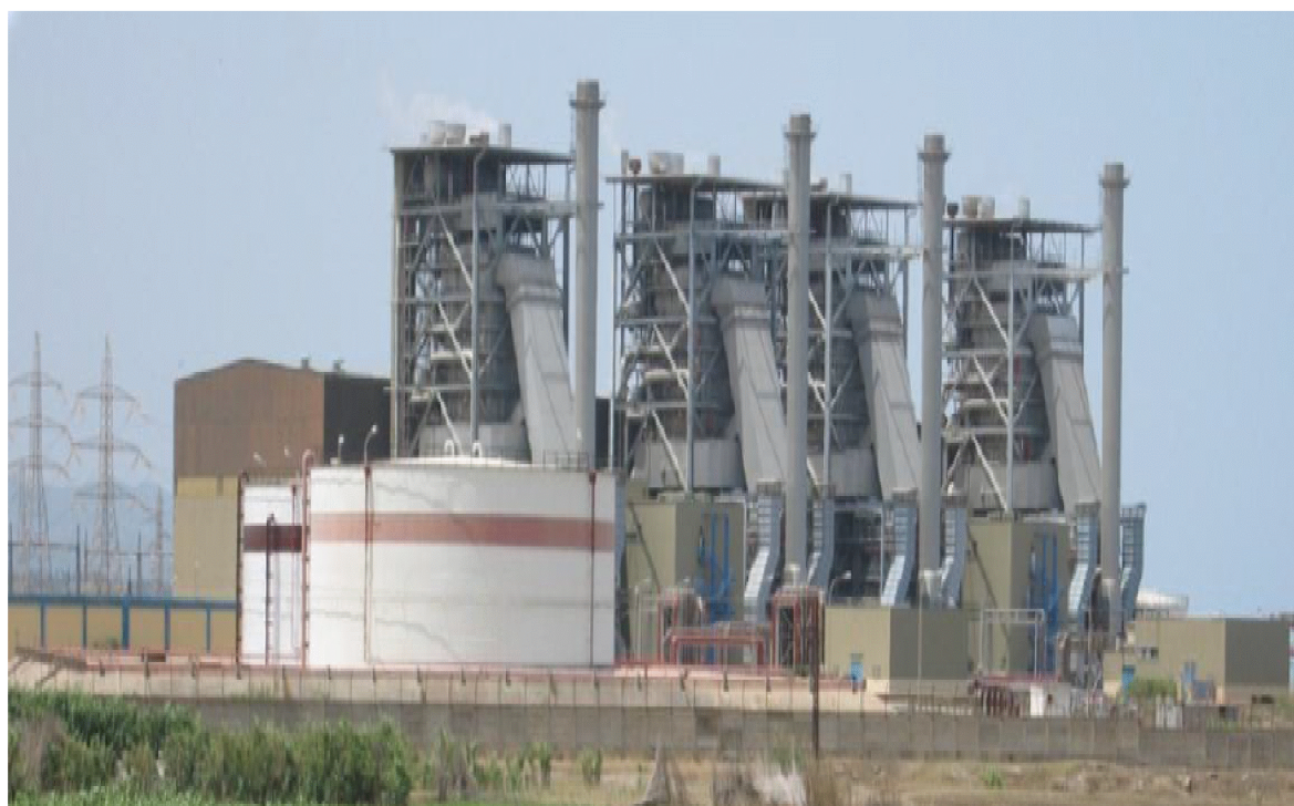
figure I. 1: La centrale thermique de RAS-DJINET.
