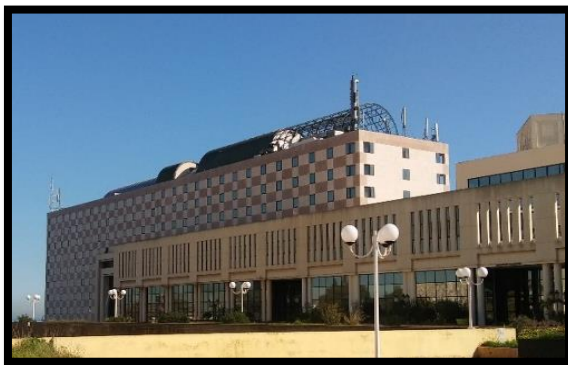
Figure 40 : hôtel Sofitel : bon état Source : photos prise par les auteurs le 30/01/2017
