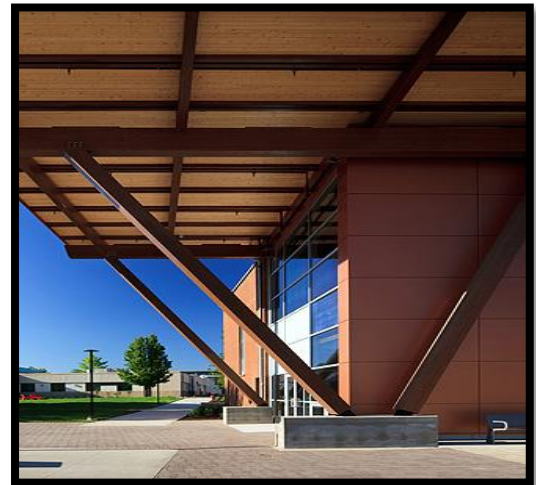
Figure 94 : porte à faux en bois Source : http://www.inlandtechnical.ca
