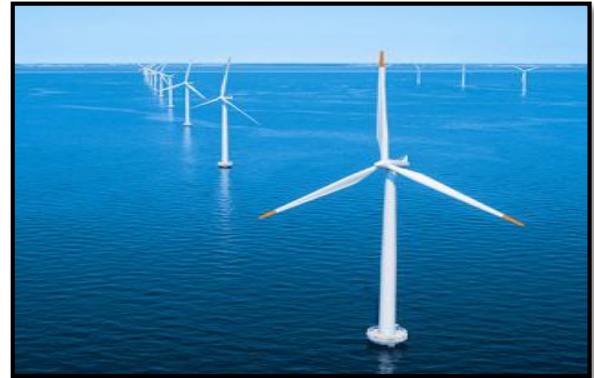
Figure 02: énergie éolienne Source : http://www.2020energy.eu
