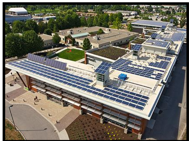
Figure 91 : vue aérien du projet Source : http://www.inlandtechnical.ca
