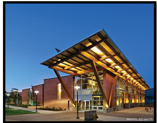
Figure 89 : vue sur le projet Source : http://www.inlandtechnical.ca
