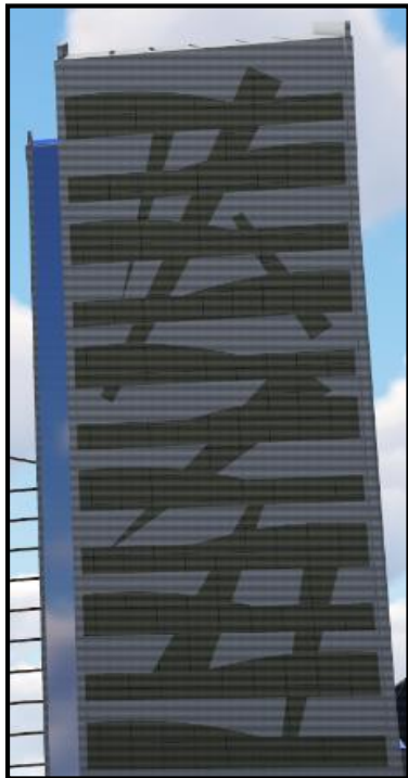
Figure 153 : façade en double vitrage Source : élaboré par les auteurs
