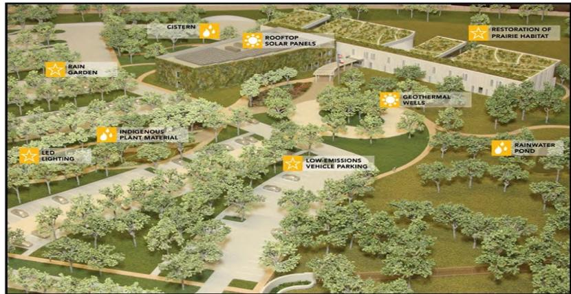
Figure 111 : Schéma mentionnant les différentes solutions bioclimatiques du BRIT
