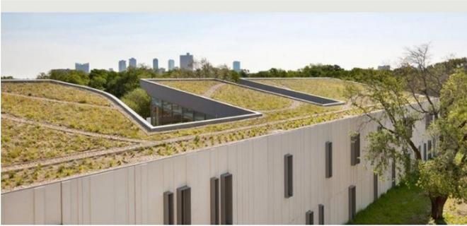
Figure 117 : toiture végétale du bloc
