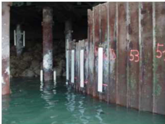
FigIII.32 : la protection anodique
