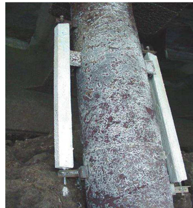
FigIII.32 : la protection anodique
