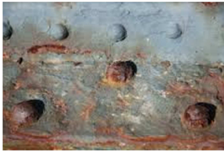
Fig III.4: la corrosion par piqures [08]
