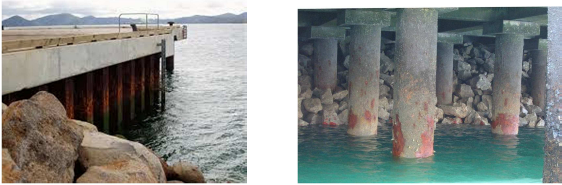
Fig III.7: les structures avec pieux métalliques [08]
