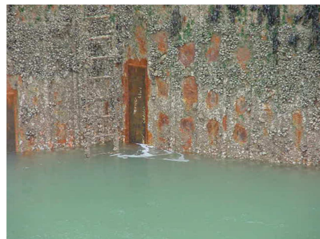
Fig III.10: Corrosions dans les basses eaux [ 08]
