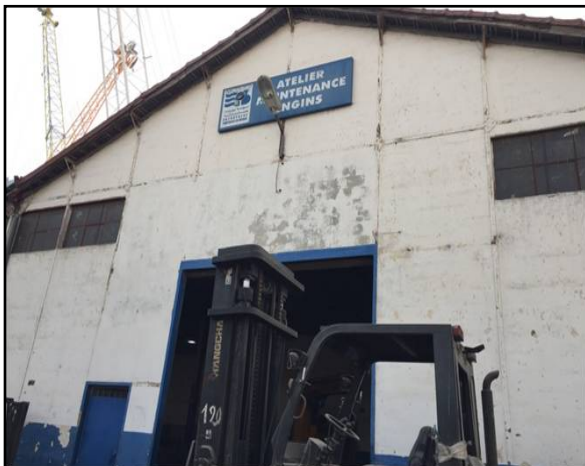
Figure 161 : Le bâti existant sur site. Source: Prise par les auteurs.
