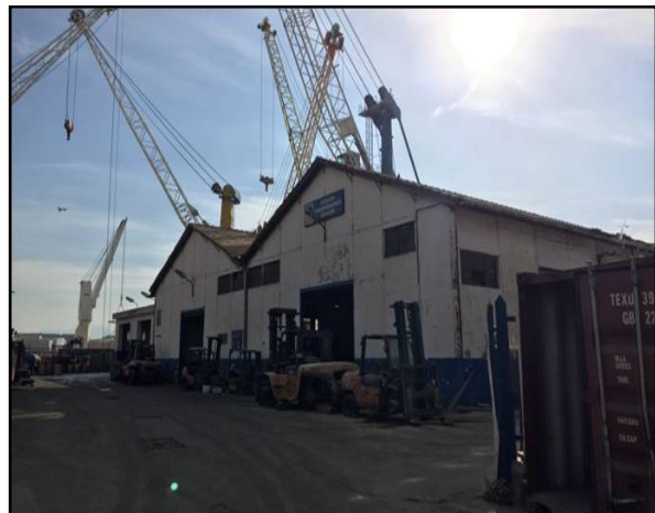
Figure 162 : Le bâti existant sur site. Source: Prise par les auteurs.
