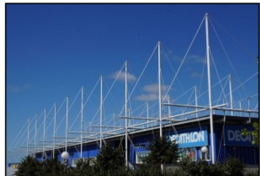
Figure 248: Structure à câbles Source : structurae.com
