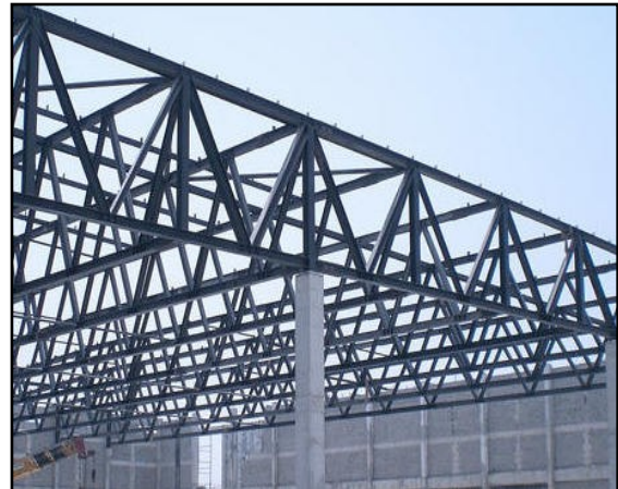
Figure 246: Illustration d'un contreventement Source : slideshare.
