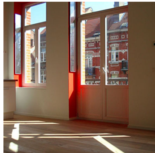
Figure10 : Mise en œuvre d'un panneau déflecteur/Source : https://www.batiproduits.com/fiche/produits/panneau-deflecteur-pour-optimisation-de-l-eclair-p69133003.html .
