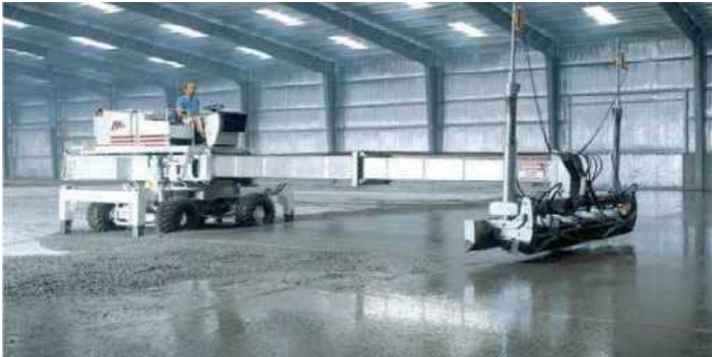
Figure II.5 : Utilisation des fibres métalliques dans les dallages industriels [32].
