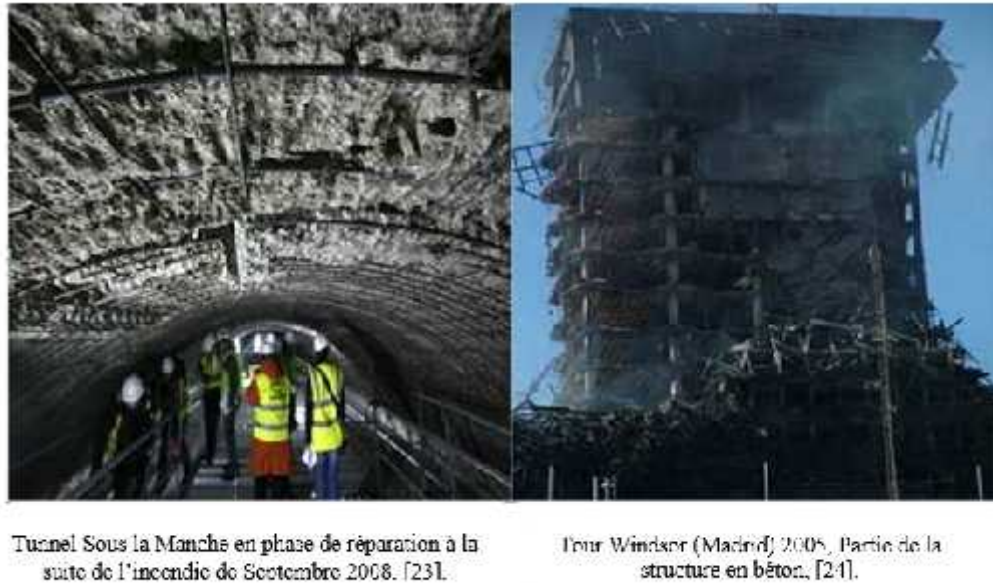
Figure III.1 : Illustrations de dégradations d'ouvrages en béton à la suite d'une sollicitation thermique [50-51].
