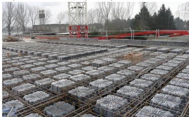
Figure 190 : le coffrage du plancher à caisson
