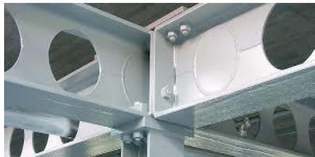
Figure 188 : fixation poteau-poutre
