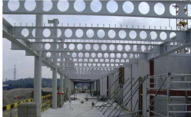
Figure 186 : les poutres alvéolaires
