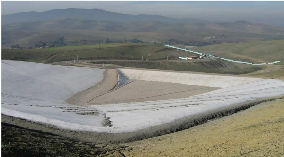
**Figure 07(b) :** Deuxième casier en cours de réalisation d'une capacité de stockage de  $450000\text{m}^3$  (Photo originelle 2015).
