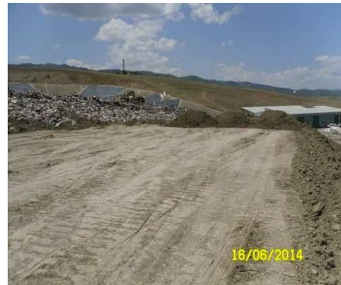
**Figure 11-b :** Recouvrement des déchets (EPWG CET, 2014).
