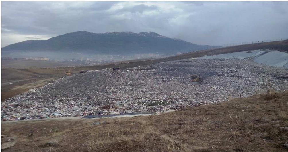
**Figure 07 (a):** Premier casier d'une capacité de stockage de 360000 m<sup>3</sup> (Photo originelle 2015).
