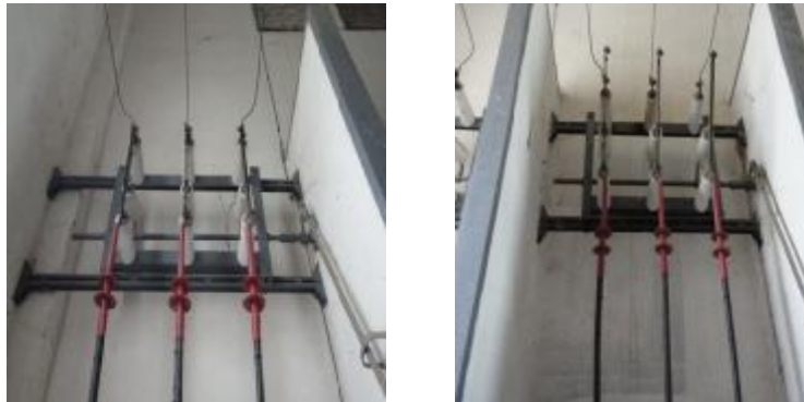
Figure 4-6- Les sectionneurs d'arrivée ouverts et fermés
