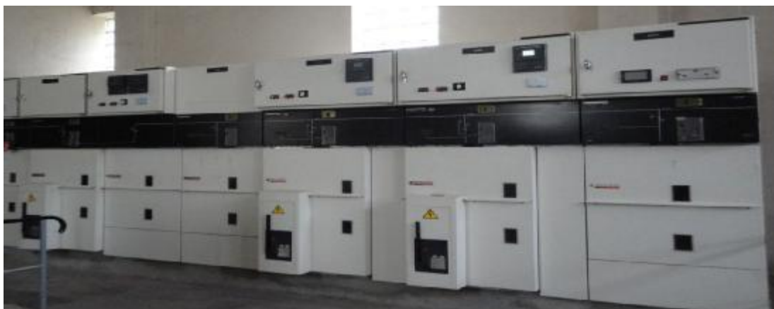
Figure 4-7- Cellule d'arrivée moyenne tension (cellule SM6)
