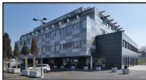
Figure 71 : bâtiment multifonctionnel Chemin des Lentillères 24 Source : http://images.app.goo.gl/gg4zh5bvi
