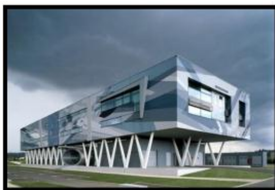
Figure 123 : poteaux inclinés de la faculté des sciences à Agen
