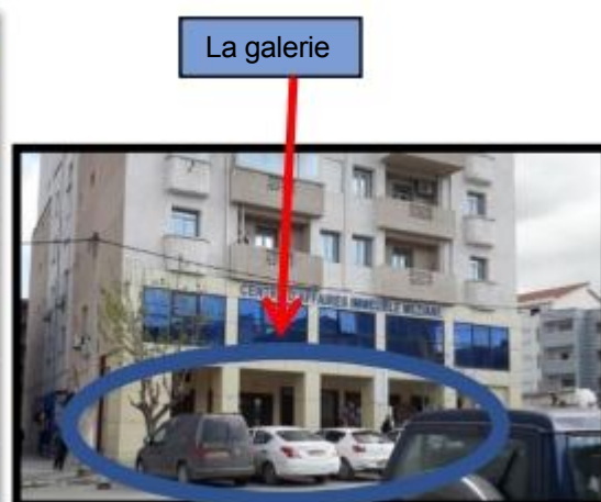
Figure 29 : galerie de l'immeuble MEZIANE Source : auteurs
