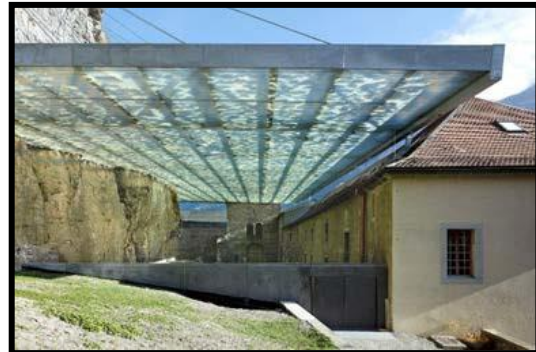
Figure 69 : couverture des ruines en vitrage. Source : https://www.google.com
