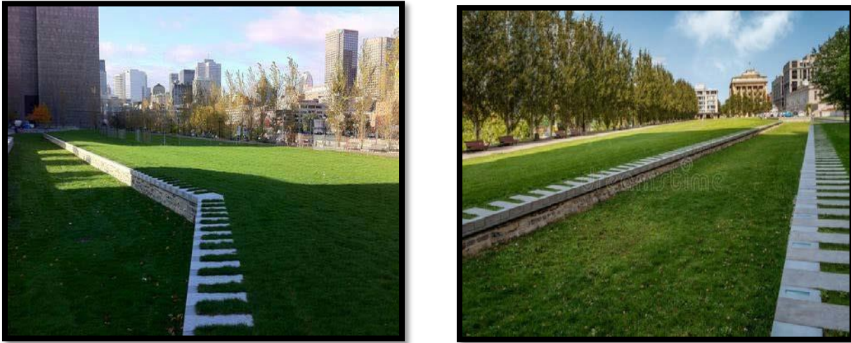
Figure 17 : Restauration des vestiges du 18e siècle des murs des fortifications de Montréal
