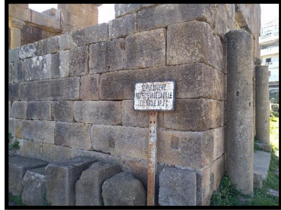
Figure 59: état actuelle des panneaux Source : prise personnelle
