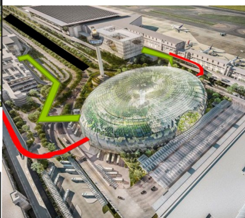
Figure 104 : environnement emmediat source : https://www.safdiearchitects.com/ traité par auteur
