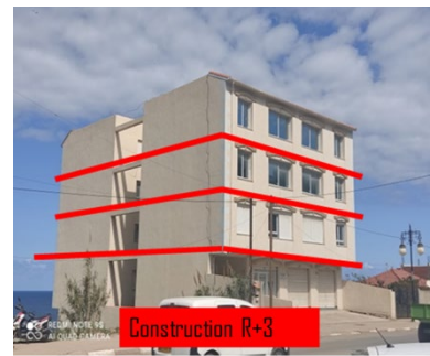
Figure 46 : construction gabarit R+3 source : auteur
