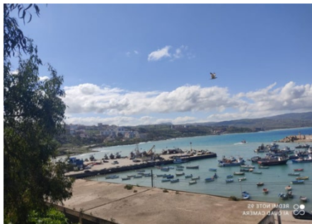
Figure 7: port de Dellys. Source: auteurs.
