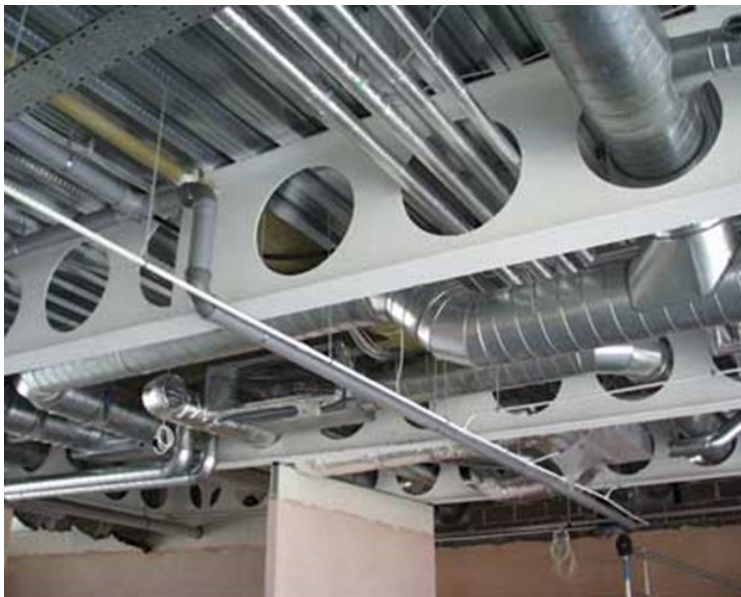
Figure 174 : les poutres alvéolaires source : https://www.detailsdarchitecture.com/
