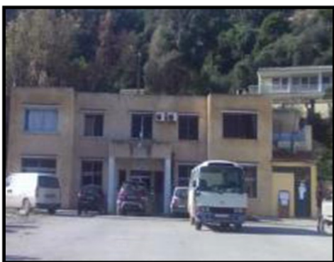
Figure 33 : SLEP source : auteur
