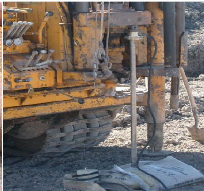
Fig. III.20. Dispositif de battage de l'essai SPT.
