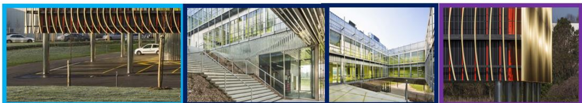
Accès mécanique Entrée du bâtiment Aspect fortifié du bâtiment
