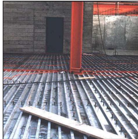
**Fig.207 :** Coffrage en tôle d'acier nervuré
