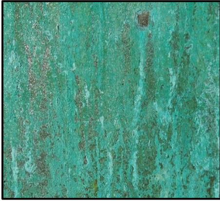
**Fig.117** : Le bardage de cuivre oxydé
