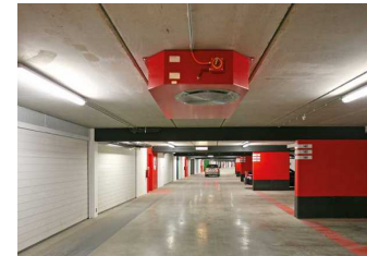
Figure 150: ventilation dans le parking ; source: www.google image
