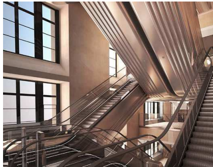
Figure 145: Exemple sur escalators source: www.pinterest.com
