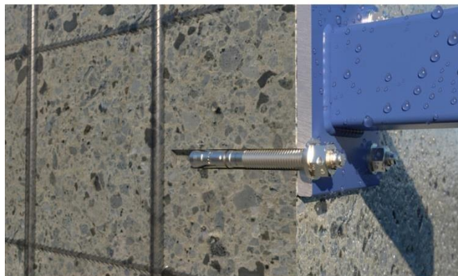
Figure VI.6 : Goujons d'ancrage M16 x 90 mm
