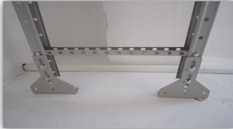
Figure IV.7: Un chemin de câble positionné.
