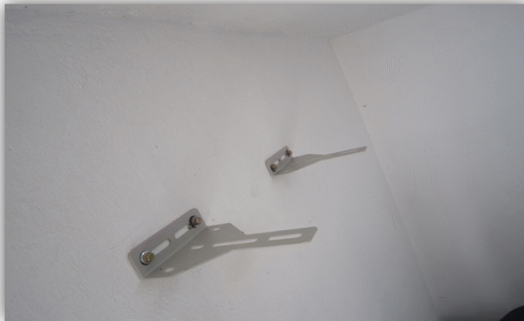
Figure IV.6: Fixation des équerres.
