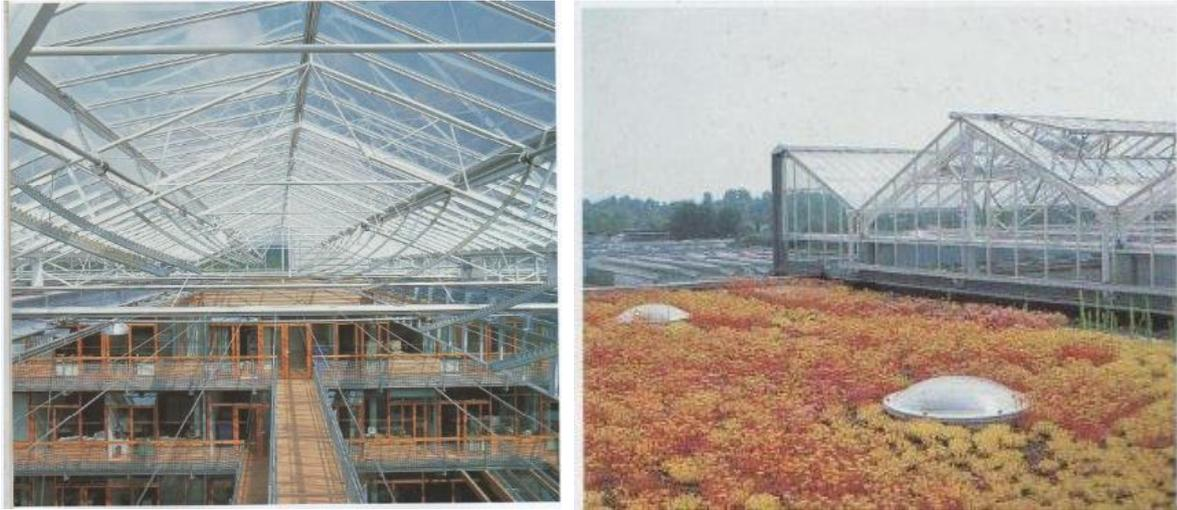
**Figure n°11 et 12** : image qui montre les passerelles et les coursives ; la toiture de l'atrium+couverture végétale
