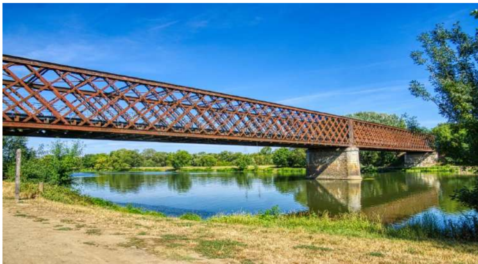
Figure I. 3: Pont à poutre à treillis.
