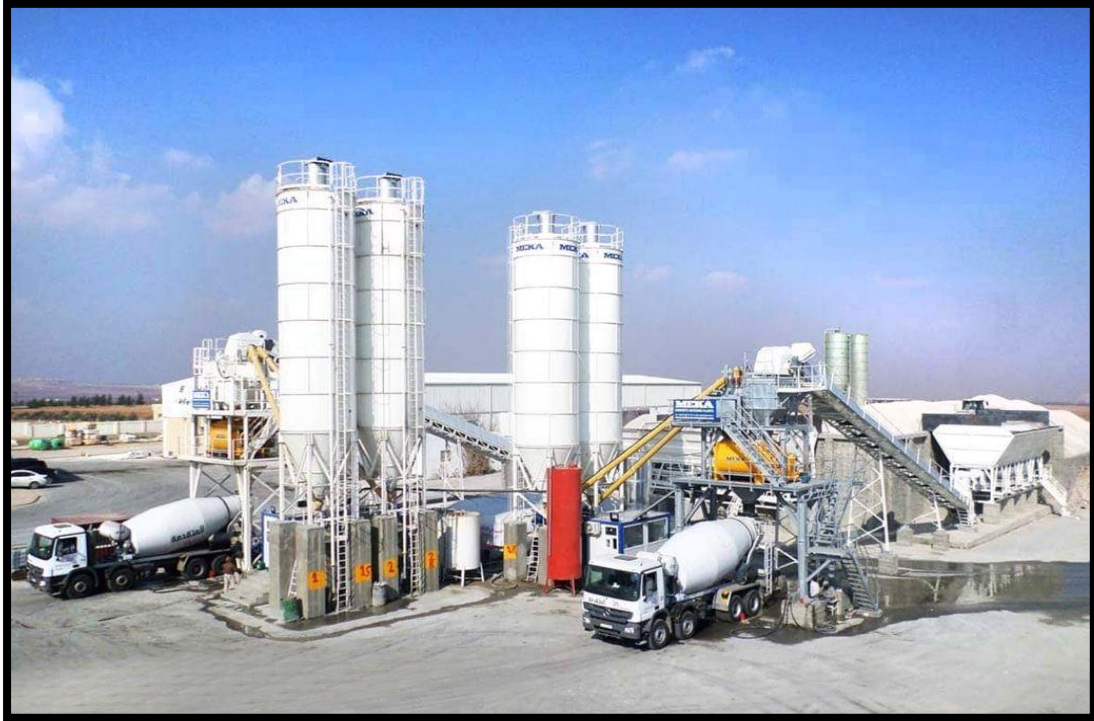
Figure I.4: Centrale à béton fixe
