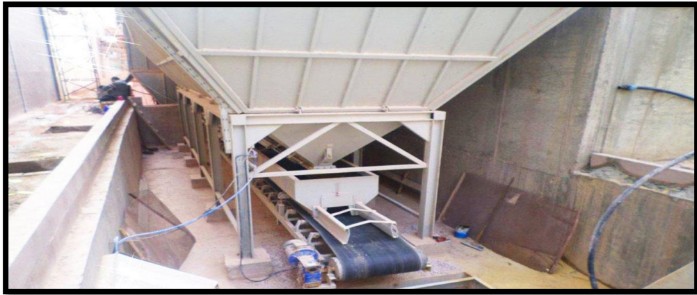
Figure I.8: Tapis convoyeur peseur
