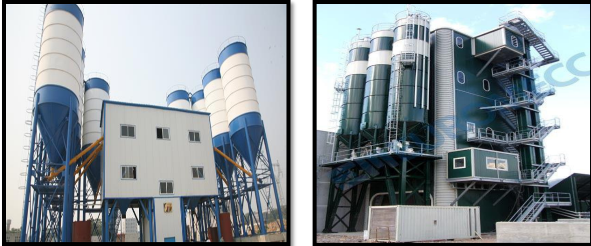
Figure I.1: Centrales de type tour à béton
