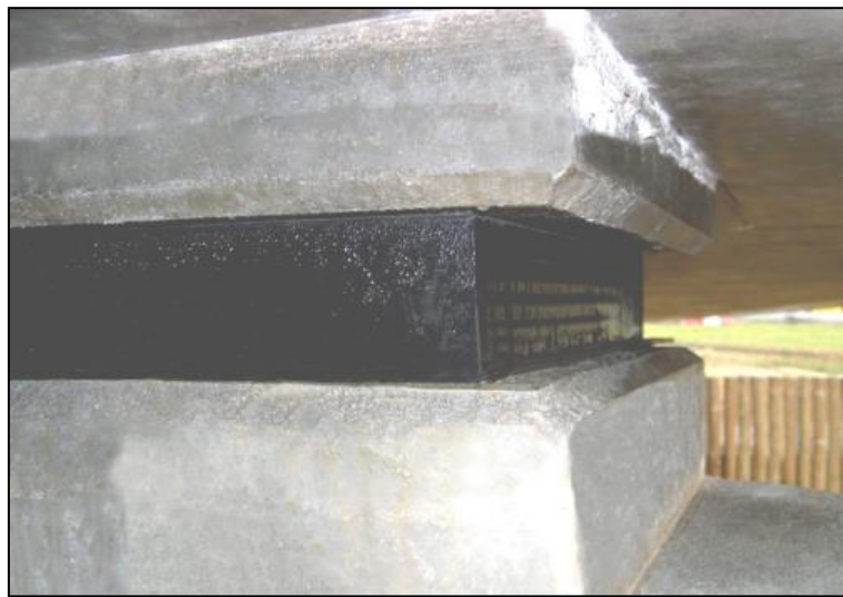
Figure IX.1: Appareil d'appui en élastomère fretté de type B.
