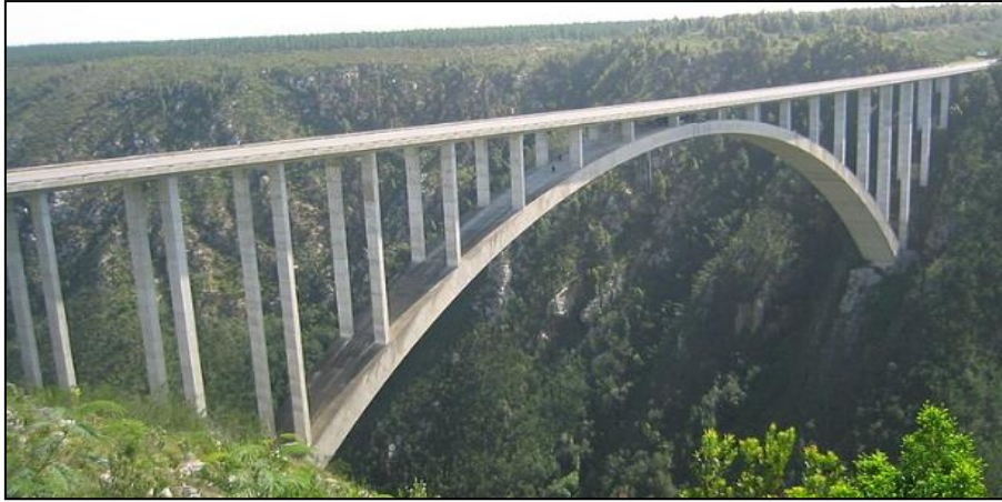
Figure I.3: Pont en arc.
