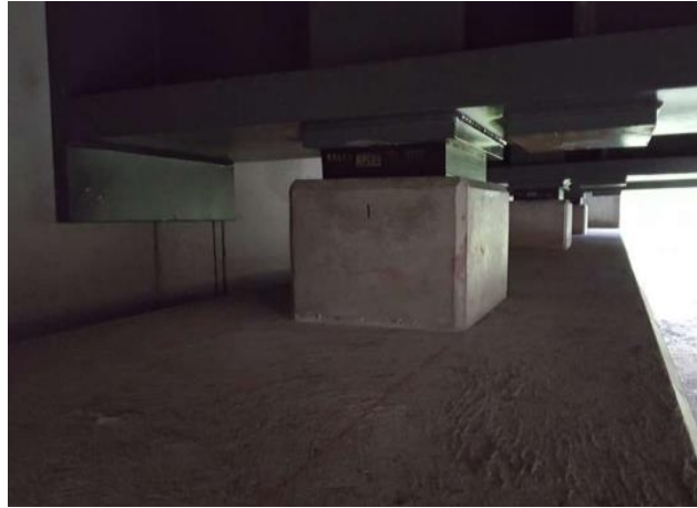
Figure II.3: Appareils d'appuis d'un pont.
