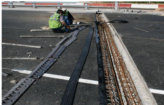
Figure II.4: Pose d'un joint de chaussée d'un pont.
