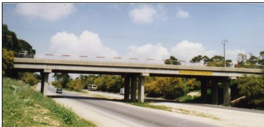
Figure I.2: Pont à poutre.
