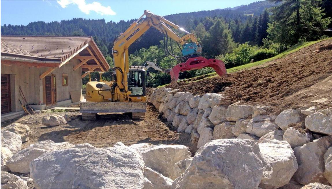
Figure I. 32: Mise en place d'un enrochement de talus.
