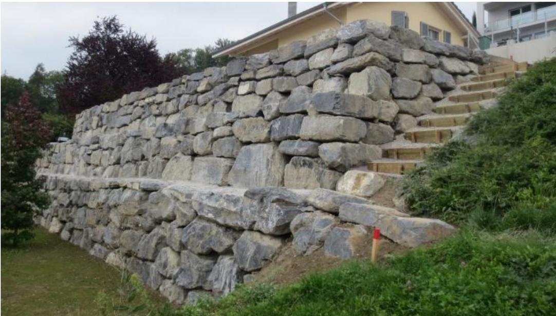
**Figure I. 34:** Enrochement de soutènement.
