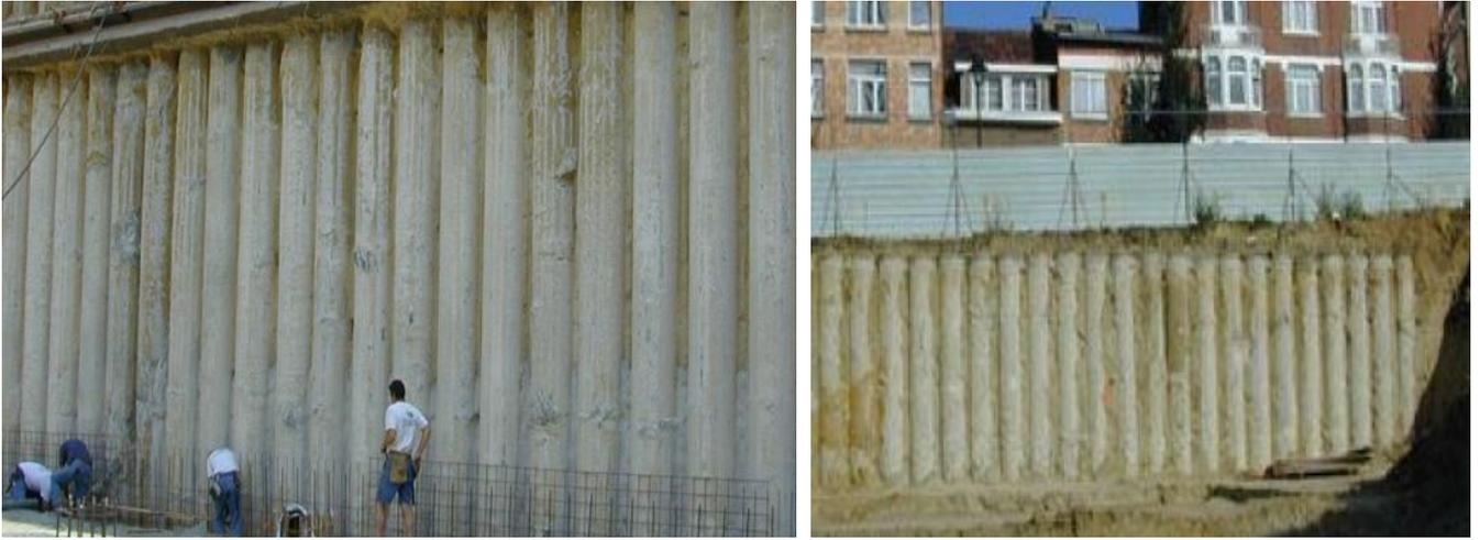
**Figure I. 40:** Stabilisation du talus par une paroi de pieux forés tubés, Belgique.
