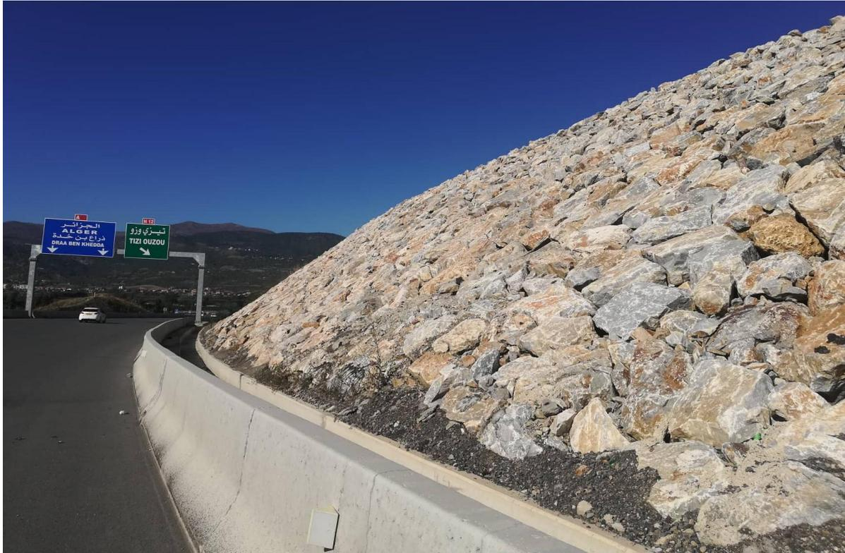
**Figure I. 36:** Enrochement de soutènement, pénétrante autoroutière au pk 0+900, Tizi-Ouzou.
