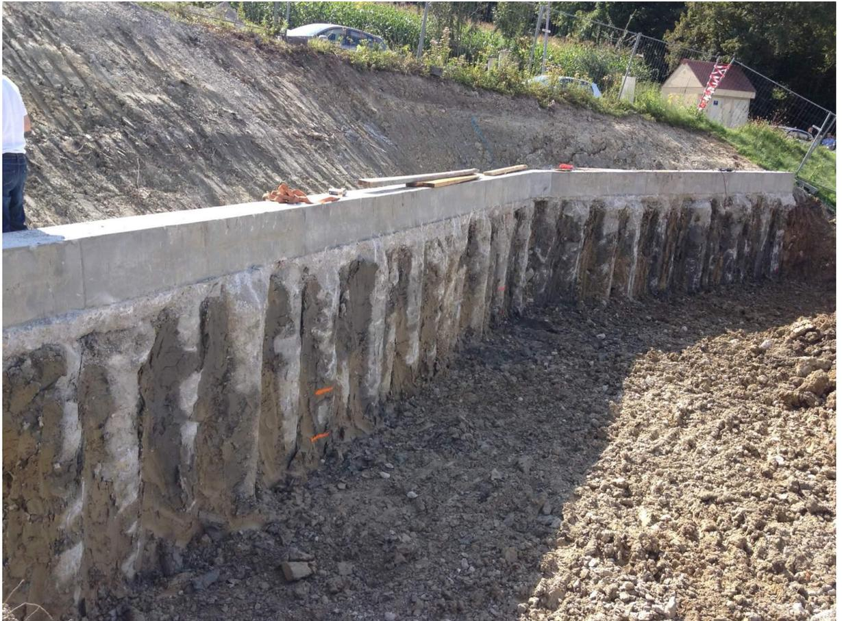
**Figure I. 41:** Stabilisation par une paroi de pieux sécants, Lyon.
