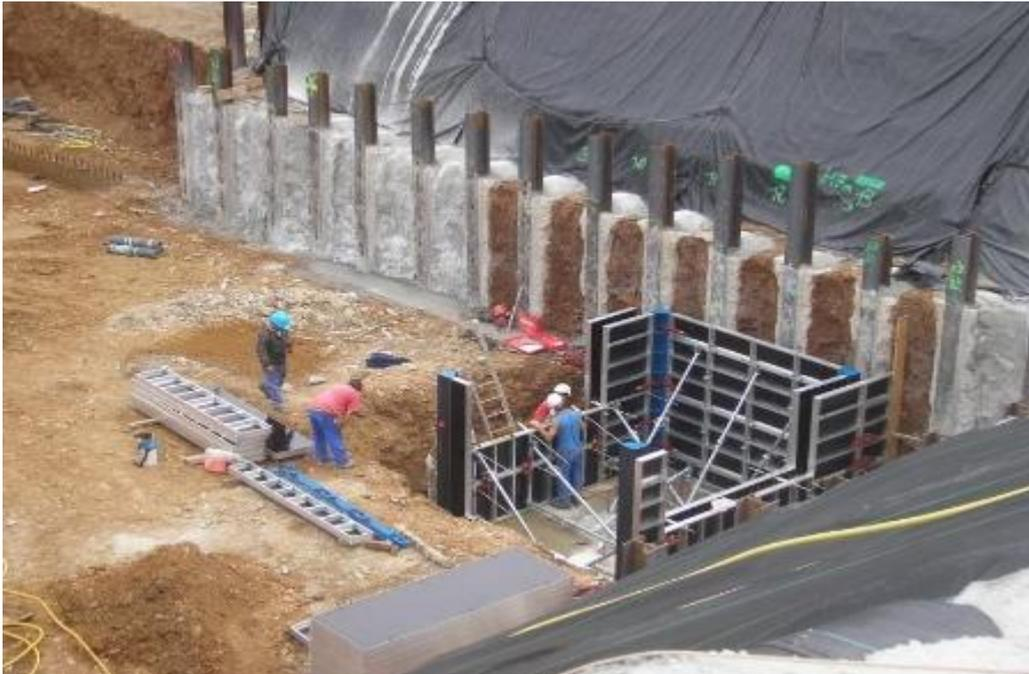
Figure I. 38: Stabilisation du talus avec des pieux en béton préfabriqués CAHORS, France.
