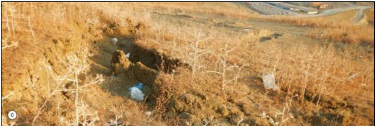
**Figure II. 9:** Fissures développées au sommet des talus.
