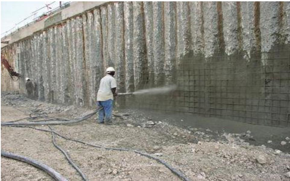
Figure I. 39: Stabilisation avec une paroi de pieux sécants recouverte d'un béton projeté, France.
