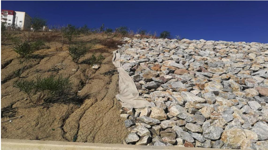
**Figure IV. 26:** Mise d'un géotextile avant la pose de l'enrochement.
