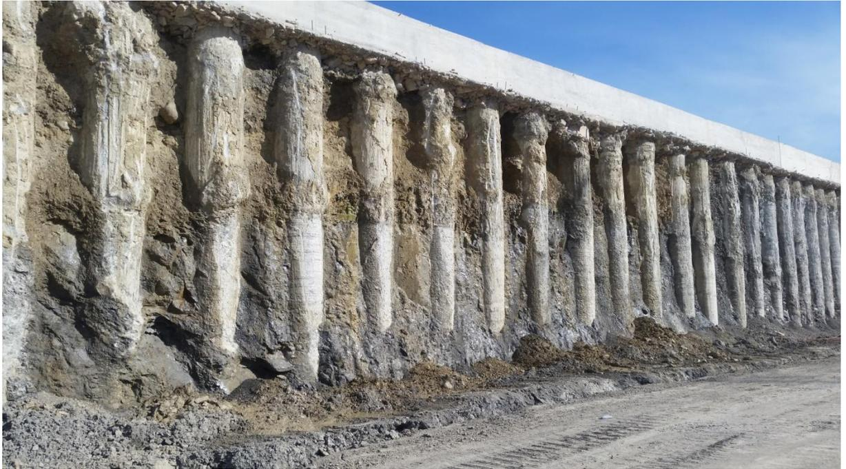
**Figure I. 42:** Stabilisation du talus par une paroi de pieux, pénétrante autoroutière, Tizi-Ouzou.
