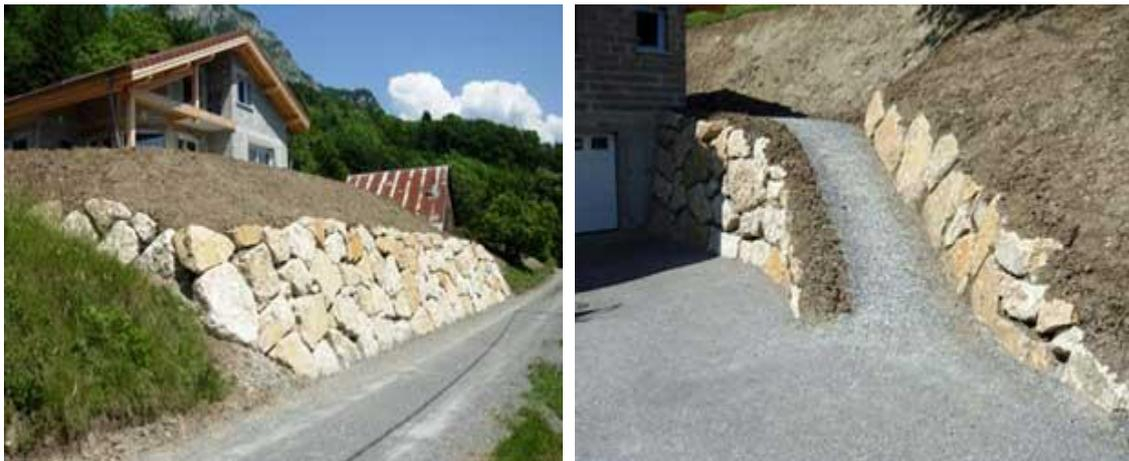
**Figure I. 35:** Renforcement du talus par encrochement a Thyez, France.
