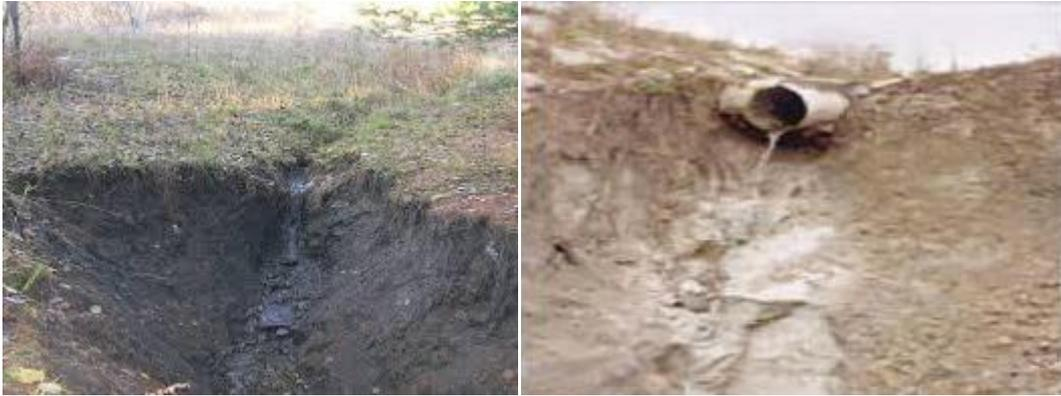
**Figure I. 24:** Exemples d'interventions qui ont pour effet de provoquer une concentration d'eau pouvant nuire à la stabilité d'un talus.
