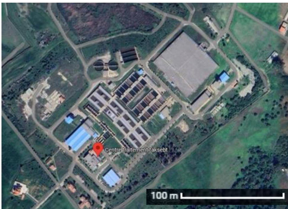
Figure I.2 : la localisation de la station de traitement TAKSEBT.
