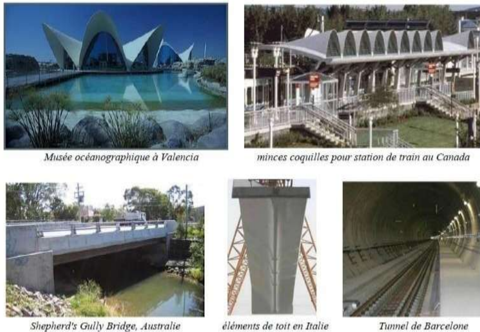
Figure I.18: Exemples d'applications du béton de fibres [18].
