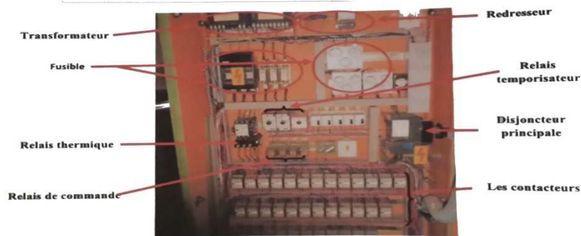
Figure III.4 Armoire électrique
