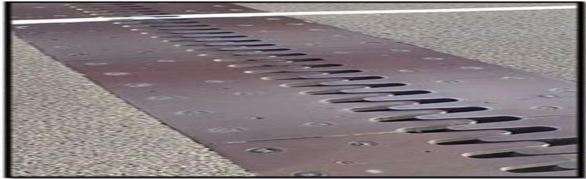
Image : Joint de chaussée
