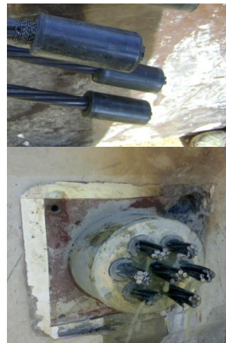
Figure XVI.17 : exemple sur l'ancrage fixe
