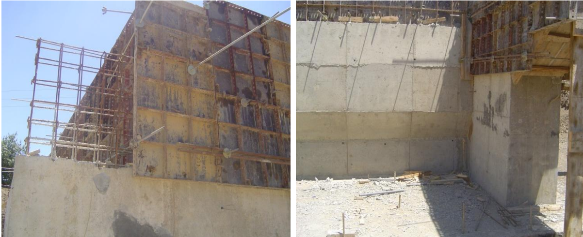
Figure XVI.9 : coffrage du mur en retour.
