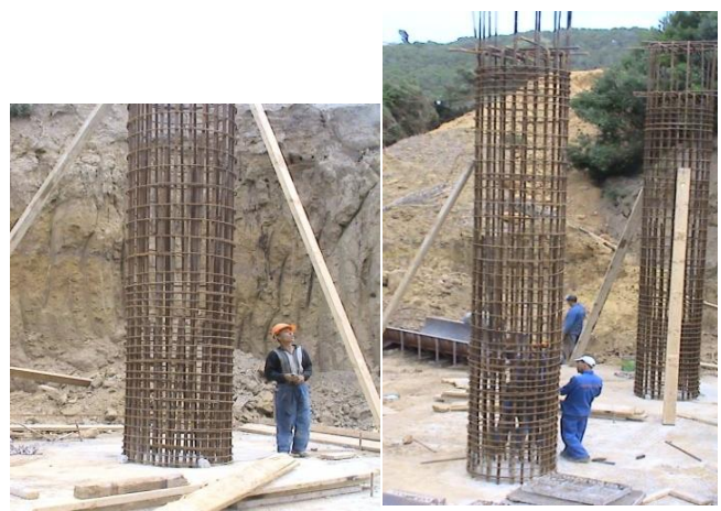
Figure XVI.6 : mise en place du ferrailage du fut
