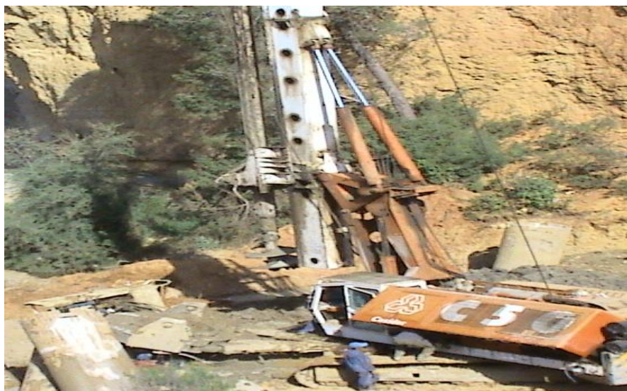
Figure XVI.2 : le forage des pieux
