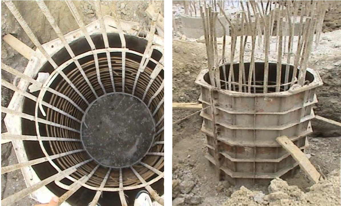
Figure XVI.3 : armatures de pieu
