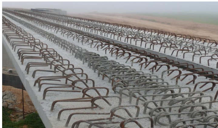
Figure XVI.11 : exemple sur armatures de jonction
