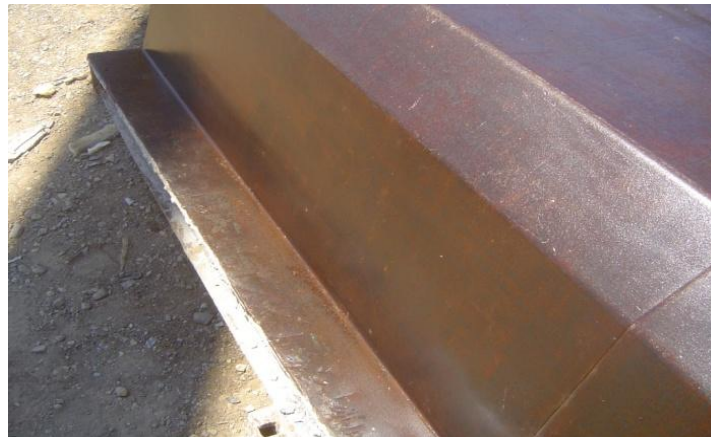
Figure XVI.12 : Coffrage+d'huile de décoffrage
