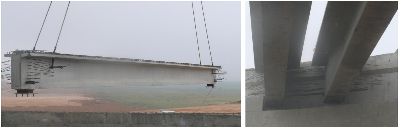
Figure XVI.10 : pose des poutres
