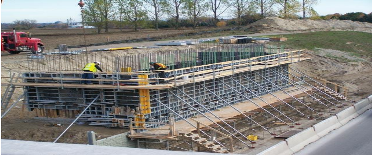
Image 1: construction d'une culée
