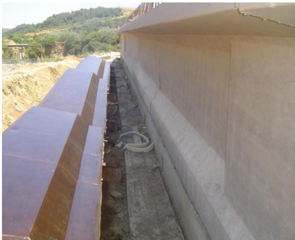
Figure XVI.16 : la forme de la poutre après décoffrage
