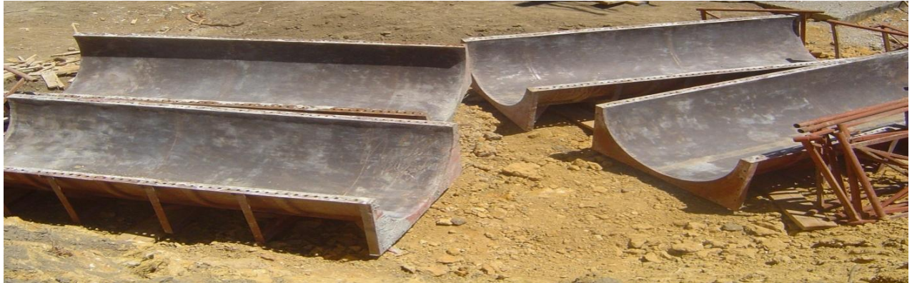
Figure XVI.7 : coffrage du fut
