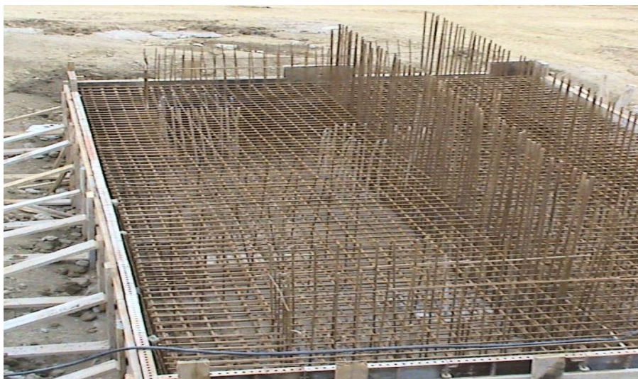
Figure XVI.5 : ferrailage de la semelle
