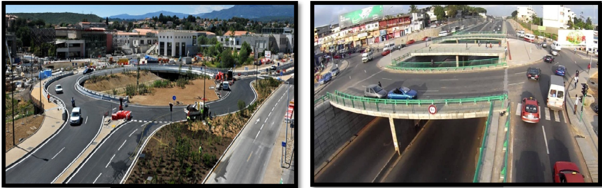
Figure 50 & 51 : Giratoires crée pour le quartier.
