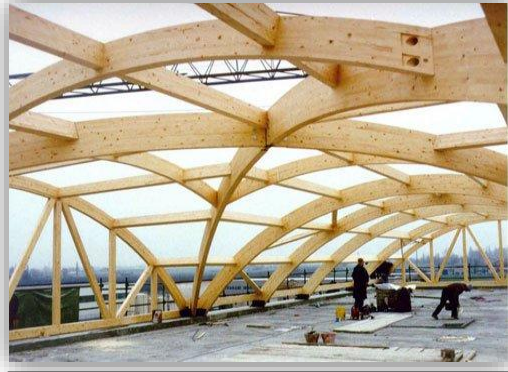
Figure 47 : Technique du collage du bois source : https://www.ecobane.fr/test-de-collage-lamelle-colle/ .
