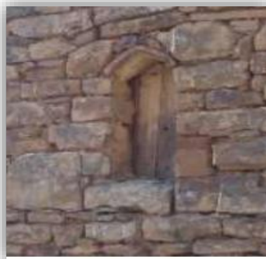
Figure 23 : Des ouvertures en pierres, en forme d'arc.
