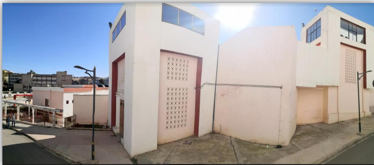
Figure102 : Façade Nord Source : Auteur
