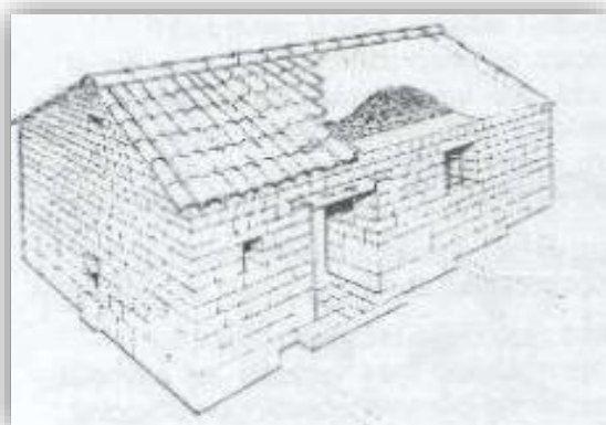
Figure10 : (assalas). Pose de la chape en mortier de terre et des tuiles.
