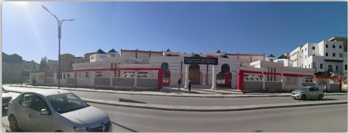
Figure 100 : Façade Est Source : Auteur
