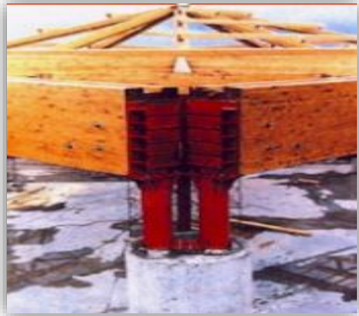
Figure 52: Assemblage collé et métallo-collé Source : https://www.ecobane.fr/test-de-collage-lamelle-colle/ .
