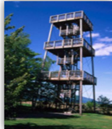
Figure 43 : Système poteaux poutres
