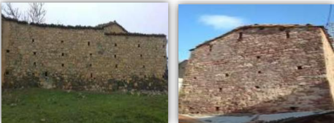
Figure 27 : Les trous de boulin dans le mur.
