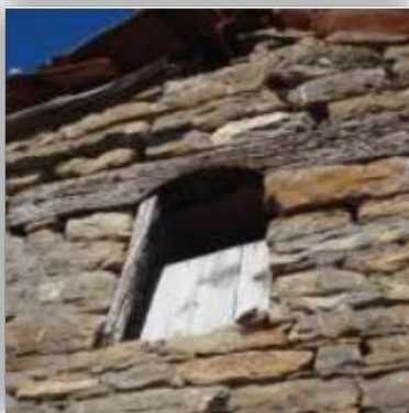
Figure 25 : Des ouvertures avec linteaux en bois
