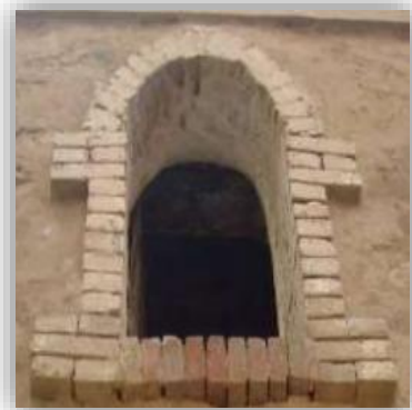
Figure 24 : Des ouvertures en terre cuite, en forme d'arc.
