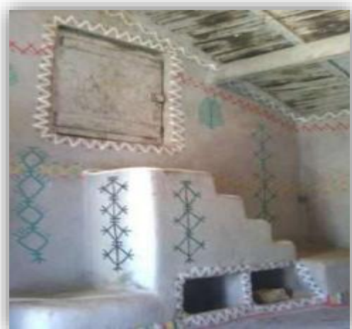
Figure 16 : Vue sur l'escalier menant vers taerict. Village Djebila, Bejaia
