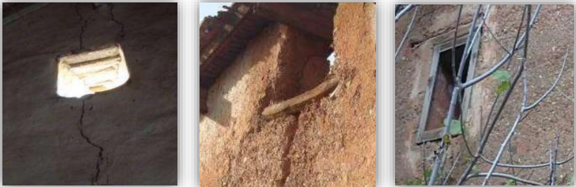
Figure 26 : Ouvertures rencontrées dans les constructions en pisé.
