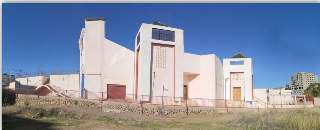
Figure103: Façade Sud Source : Auteur
