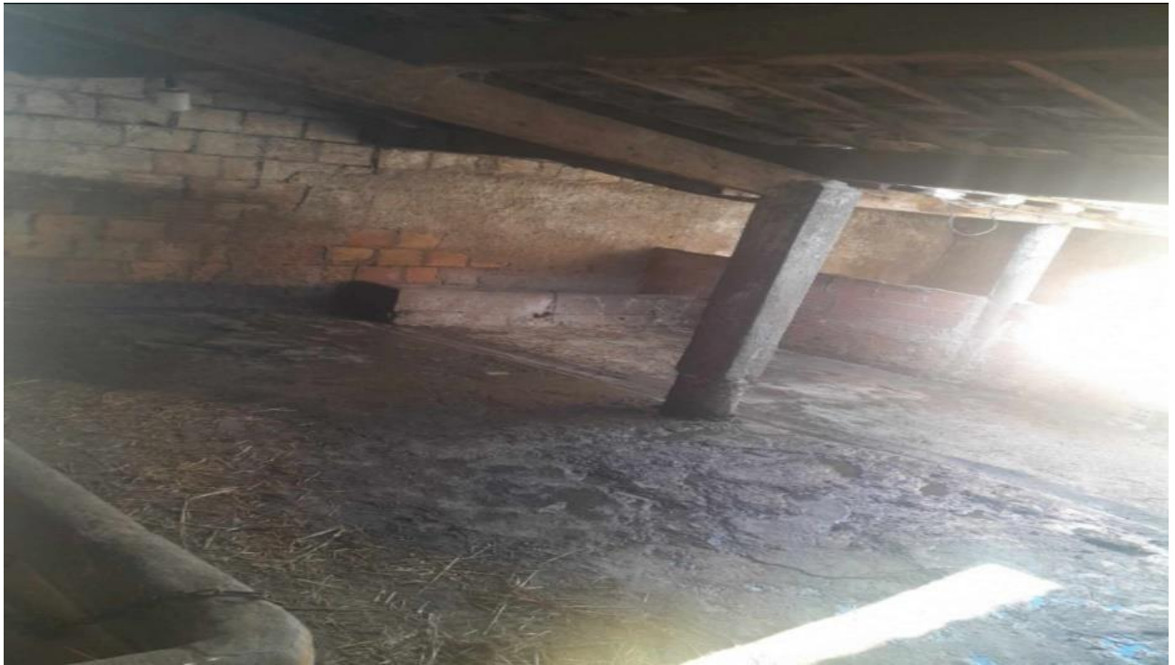
Figur.I.1 : bâtiment d'élevage traditionnel
