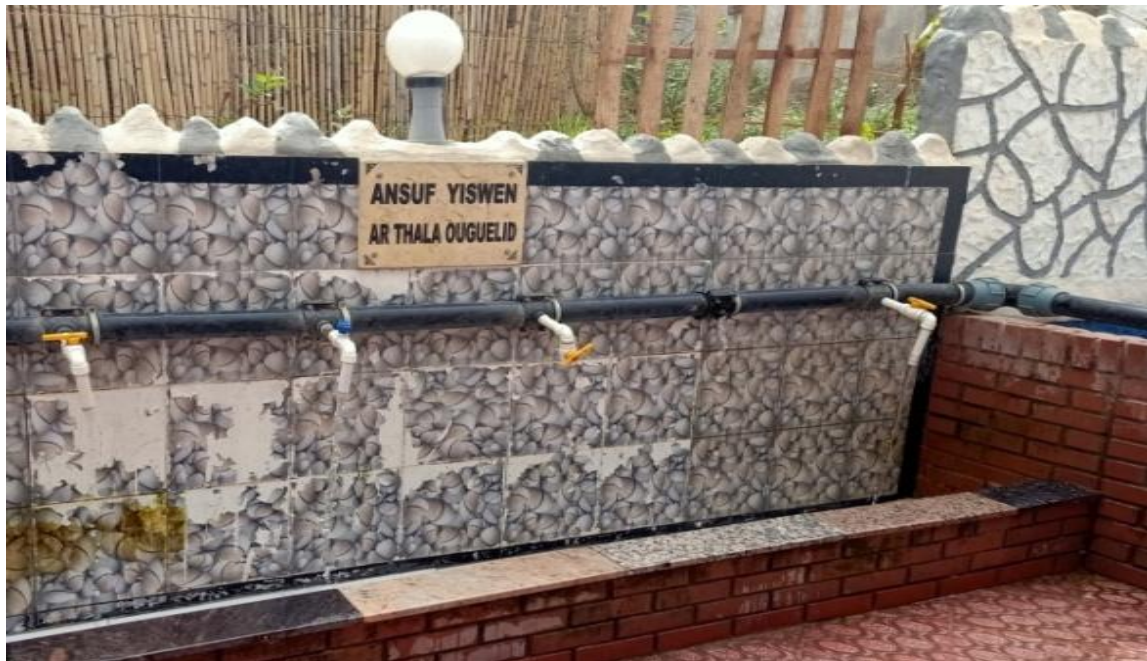
Figure 01 : photo de la source Thala Ouguelidh (photographie originale, 2022).
