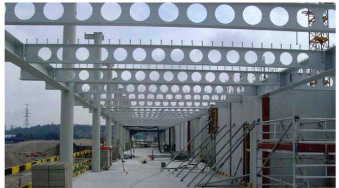
Figure 122: Les poutres alvéolaires
