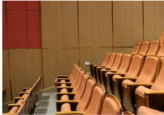
Figure 136: Panneaux de bois rainurés
