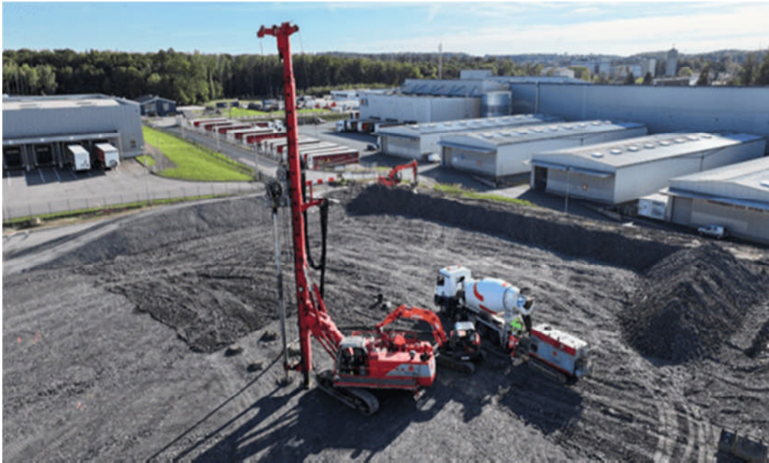
Figure I .12: Compactage par impact.
