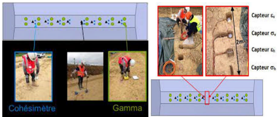
Figure I . 16: Essai de la planche sur chantier.
