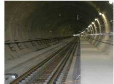
Tunnel de Barcelone
