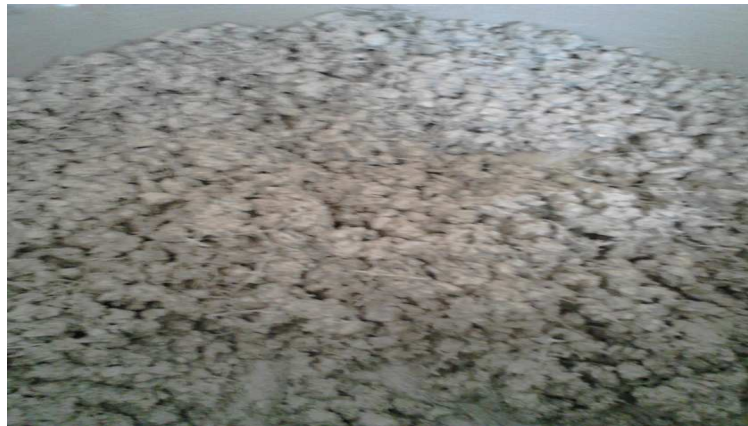
Figure IV.23: Malaxage du béton de fibres association (polypropylène et métalliques).
