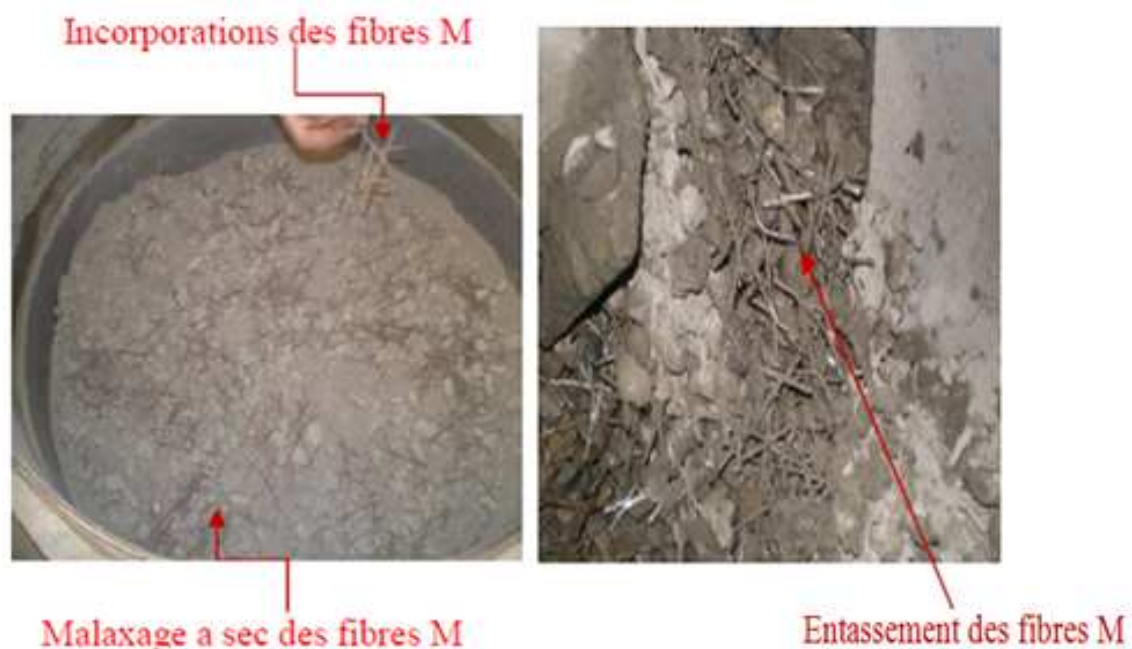
Figure IV.21: Malaxage du béton de fibres métalliques.
