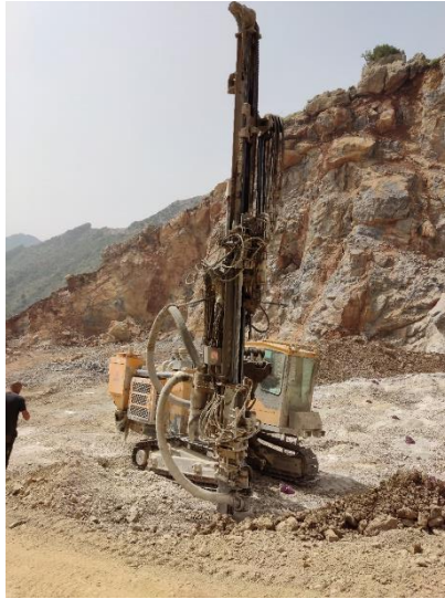
Figure 17: Photo montrant la foreuse en train de forer.
