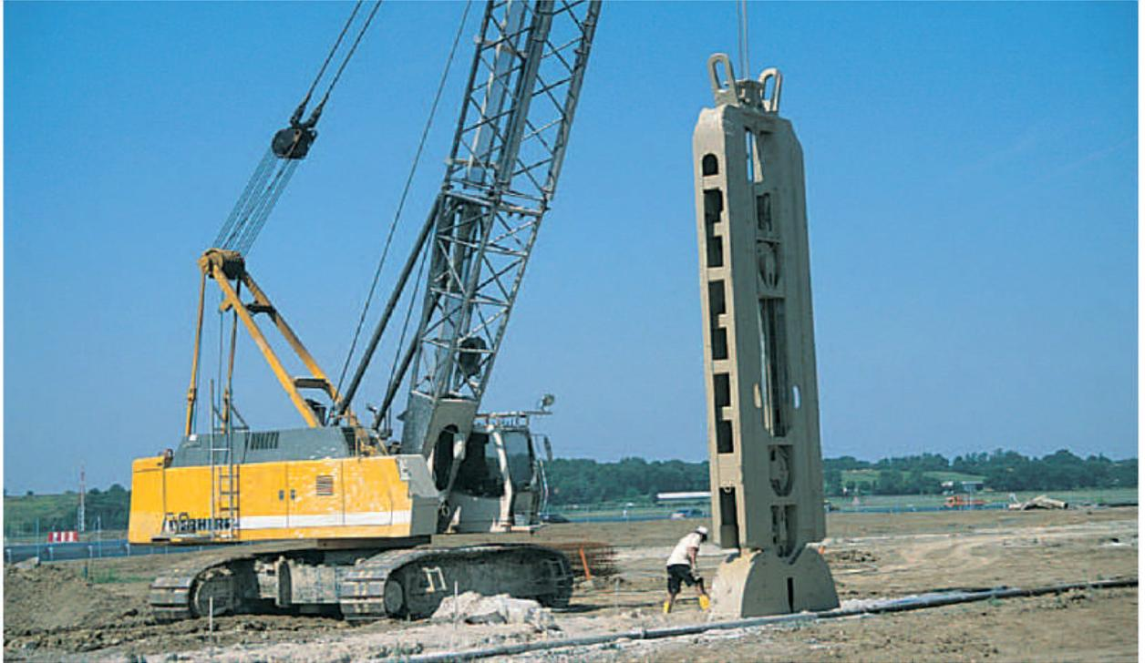
*Figure 2-1 : Creusement d'un écran étanche avec une benne à câble.*
