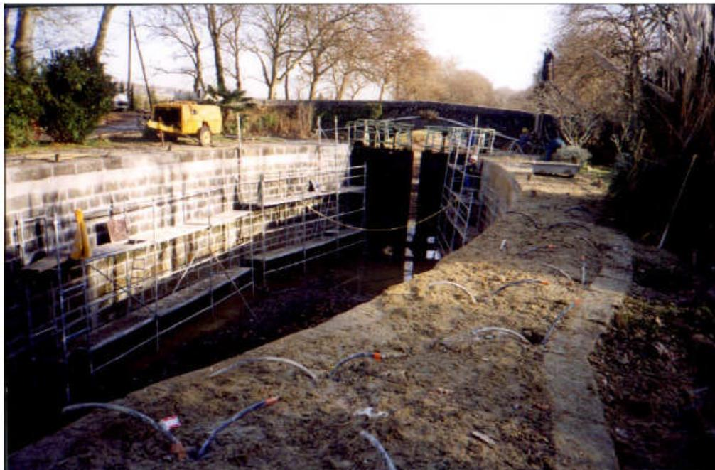
*Figure 2-8 Consolidation des murs bajoyers d'une écluse.*
