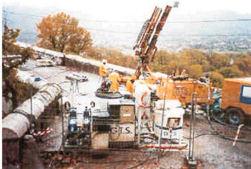
*Figure 2-9 : Atelier de forage et centrale d'injection.*
