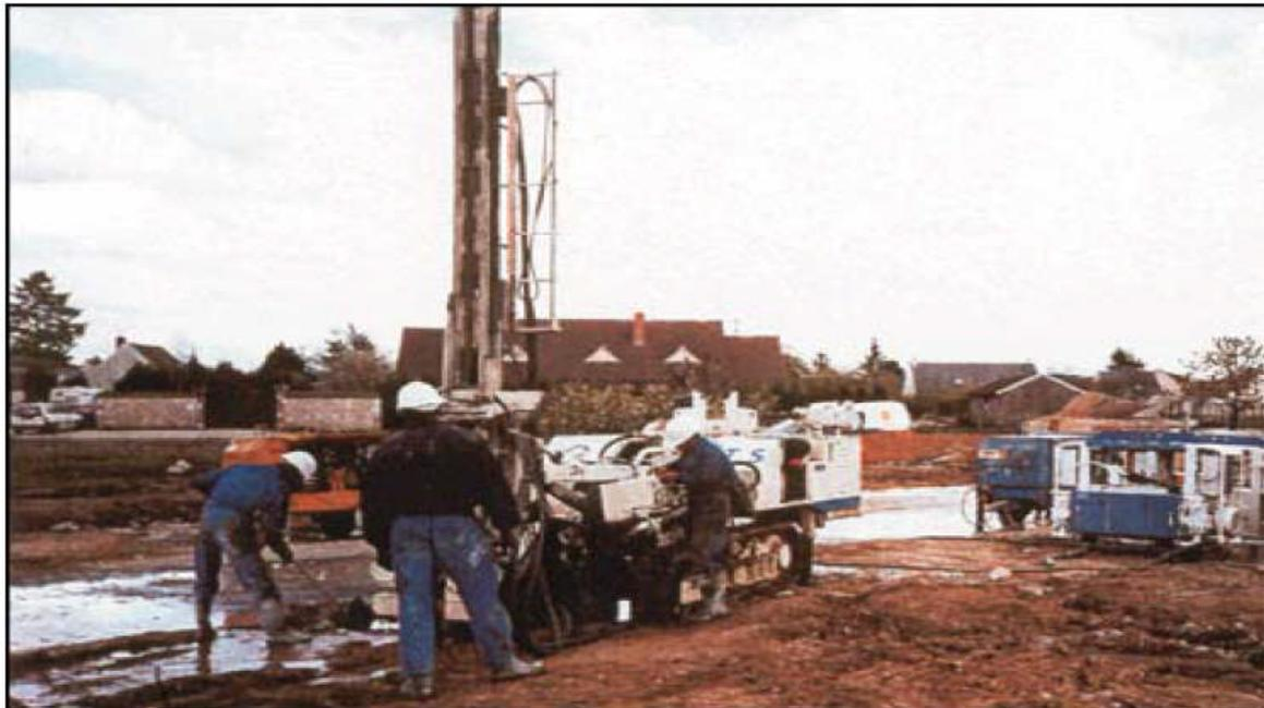
*Figure 2-1 image représentant un atelier de forage et pompes d'injection.*
