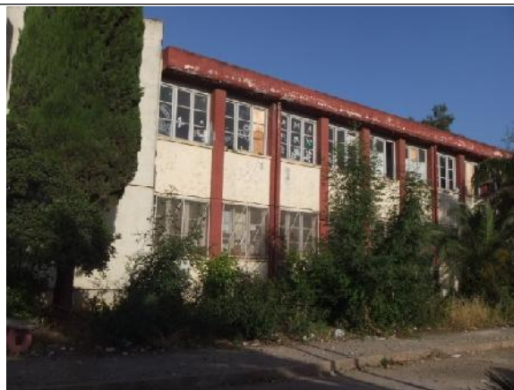
Fig 36 : vue sur la façade est. Source : Auteurs
