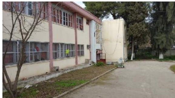
Fig 27 : Vue sur le bloc d'hébergement C
