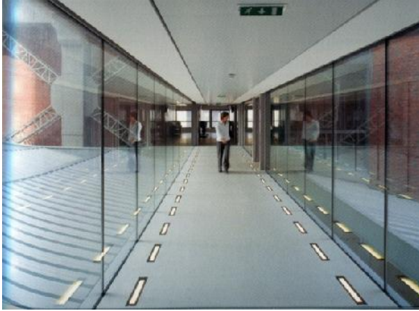
Fig 85 : Passerelle X1 Source : Borel. F. 2008
