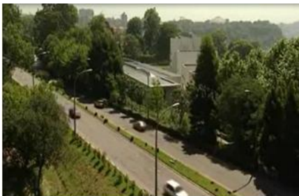
Fig 44 : Vue de l'école depuis l'autoroute
