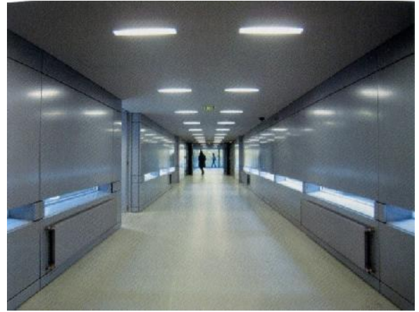
Fig 88 : Passerelle X2 Source : Borel. F. 2008
