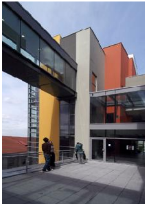
Fig 74 : Terrasse 7ème étage Source : www.paris-valdeseine.archi.fr
