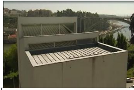
Fig 50 : Ouverture zénithale nord sur l'une des tours
