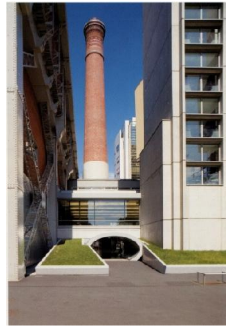
Fig 93 : Entrée sud : sas d'accès 24h sur 24 Source : Borel. F. 2008
