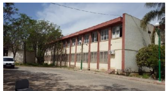
Fig 39 : vue sur la façade sud du bloc A.
