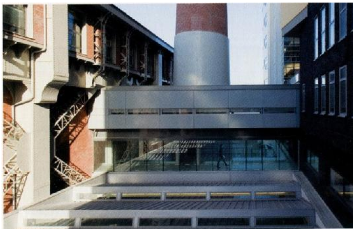
Fig 87 : Passerelle X1/X2 Source : Borel. F. 2008
