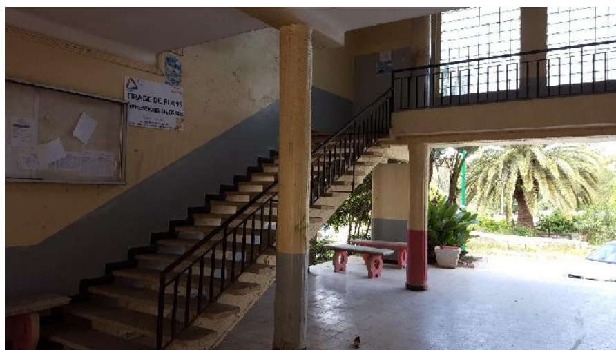
Fig 33 : Vue sur l'escalier du hall
