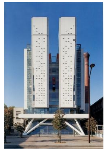
Fig 67 : Façade sur quai Source : Borel. F. 2008
