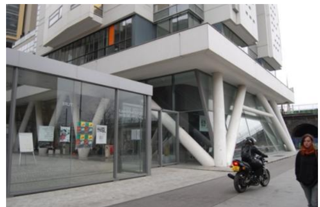
Fig 91 : Entrée principale Source : www.paris-valdeseine.archi.fr
