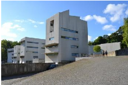
Fig 49 : Façades sud des tours
