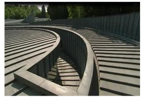
Fig 55 : Le dispositif d'éclairage zénithal vu de l'extérieur.
