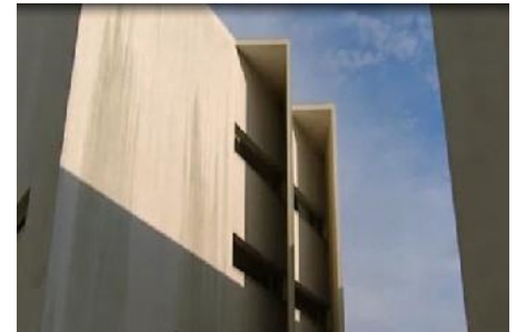
Fig 52 : Brise soleils orientés à l'ouest
