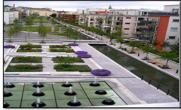
Photo 31 : Récupération des eaux Source : www.hammarbysjostad.se
