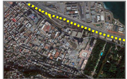
Photo 40 : Vue aérienne du la voie ferrée Source : Google earth
