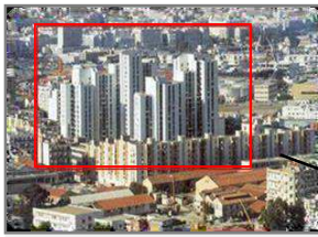
Photo33 : Ilot El Djaouhara Source : auteurs
