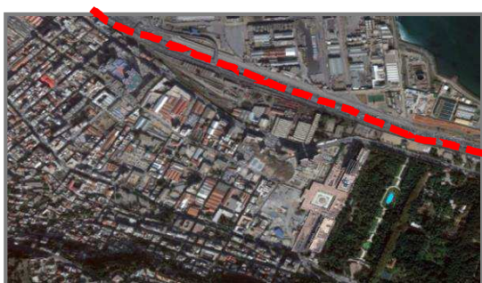
Photo41 : Vue aérienne du l'axe de l'ALN Source : Google earth
