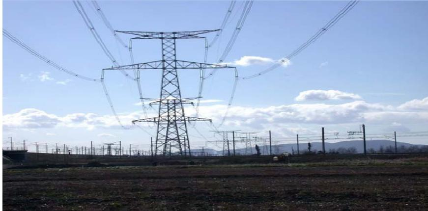
Figure I.4 : Exemple de support d'une ligne de 225 kV double terre. [Cova 2005]
