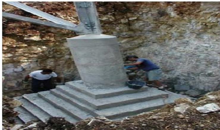
Figure I.1 Vue d'une fondation d'une ligne 400 kV. [Cova 2005]
