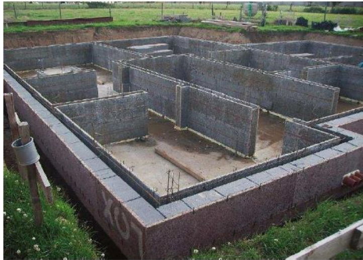
Fig.II.4. Panneaux composites bois-ciment dans les coffrages [29].
