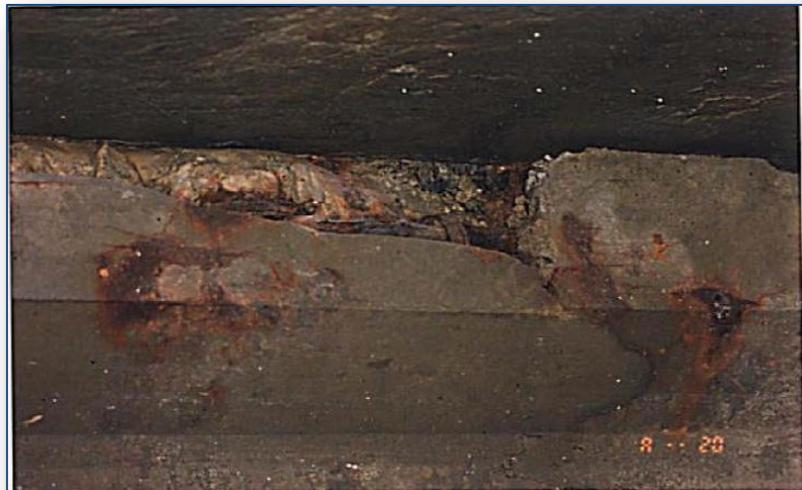
*Figure II.14. Dégradation des poutres de la plate-forme sous l'effet d'un déplacement latéral d'un ouvrage en raison de la poussée des remblais du terre-plein*
