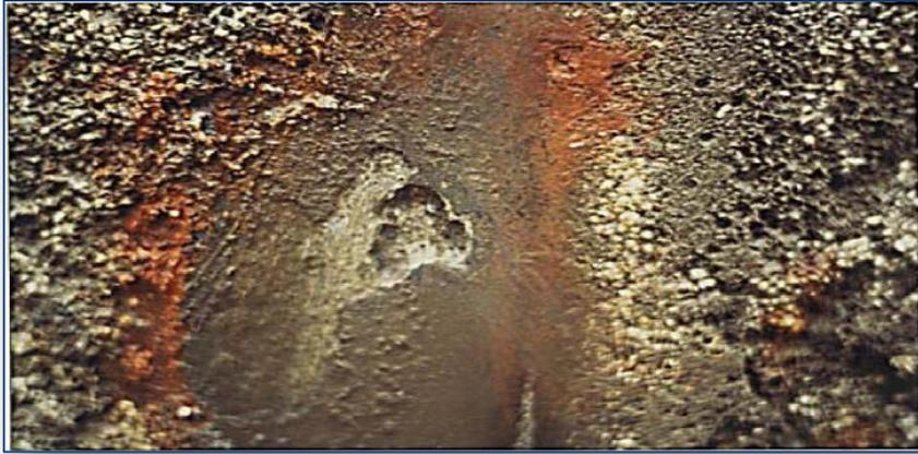
*Figure II.15. Cratère de corrosion dans la partie aérienne d'un pieu-tube*
