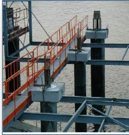
*Figure II.12. Mise en place des têtes*
