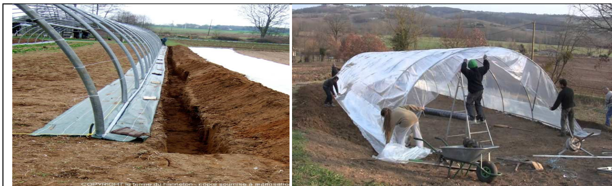
Figure5 : Construction d'une serre tunnel où l'on peut se tenir debout
